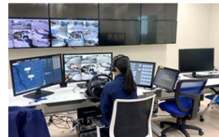
遠隔管制室(CRANTS内)
